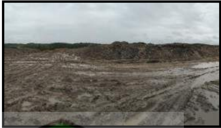
Gambar 4.9 Kondisi Permukaan Jalan Angkut Material Overburden saat keadaan licin dan lurus
